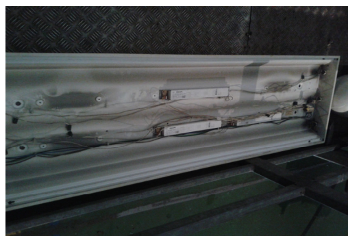
foto 6: armatuur met bedrading en schakeling
