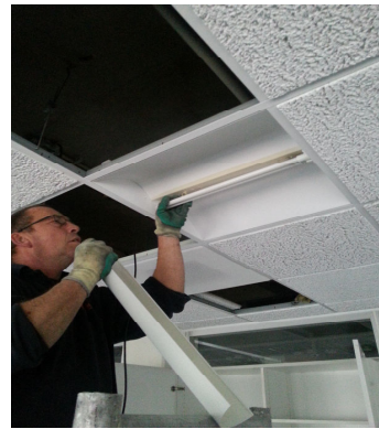
foto 4: verwijdering lampen uit armaturen
