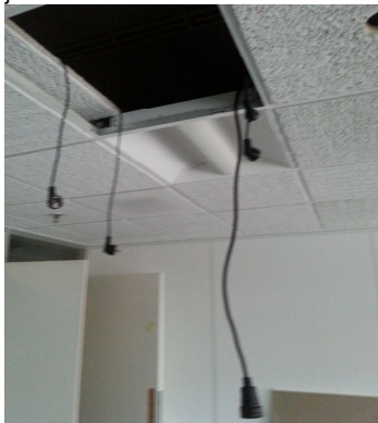
foto 3: loskoppelen bekabeling
