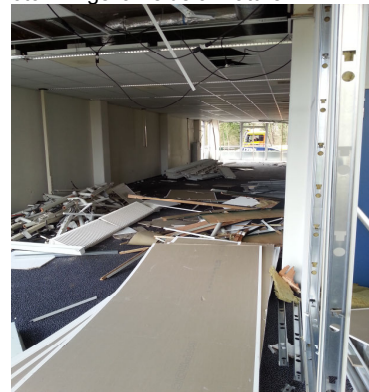
foto 6: verwijdering systeemplafond
