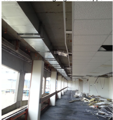
foto 5: kantoren tijdens ontmanteling
