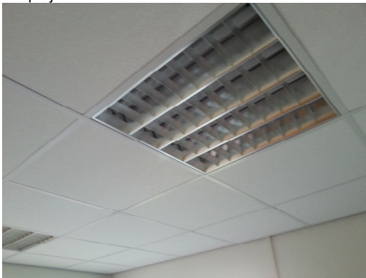
foto 3: armaturen gangen en trappenhuizen
