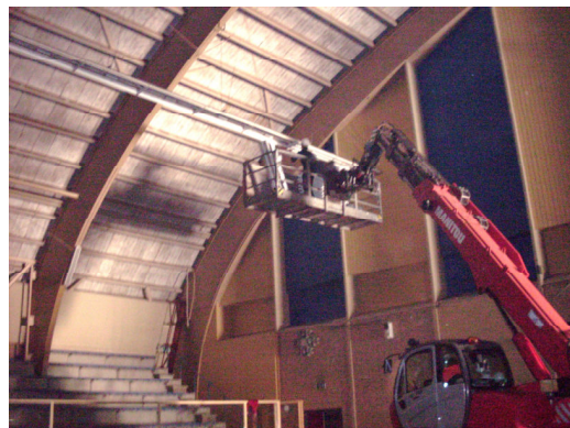
foto 2: verwijdering armaturen sporthal
