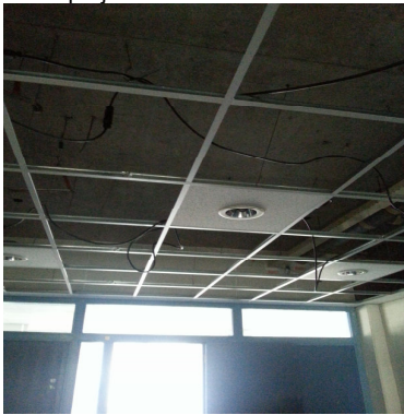
foto 3: armaturen gangen en trappenhuizen
