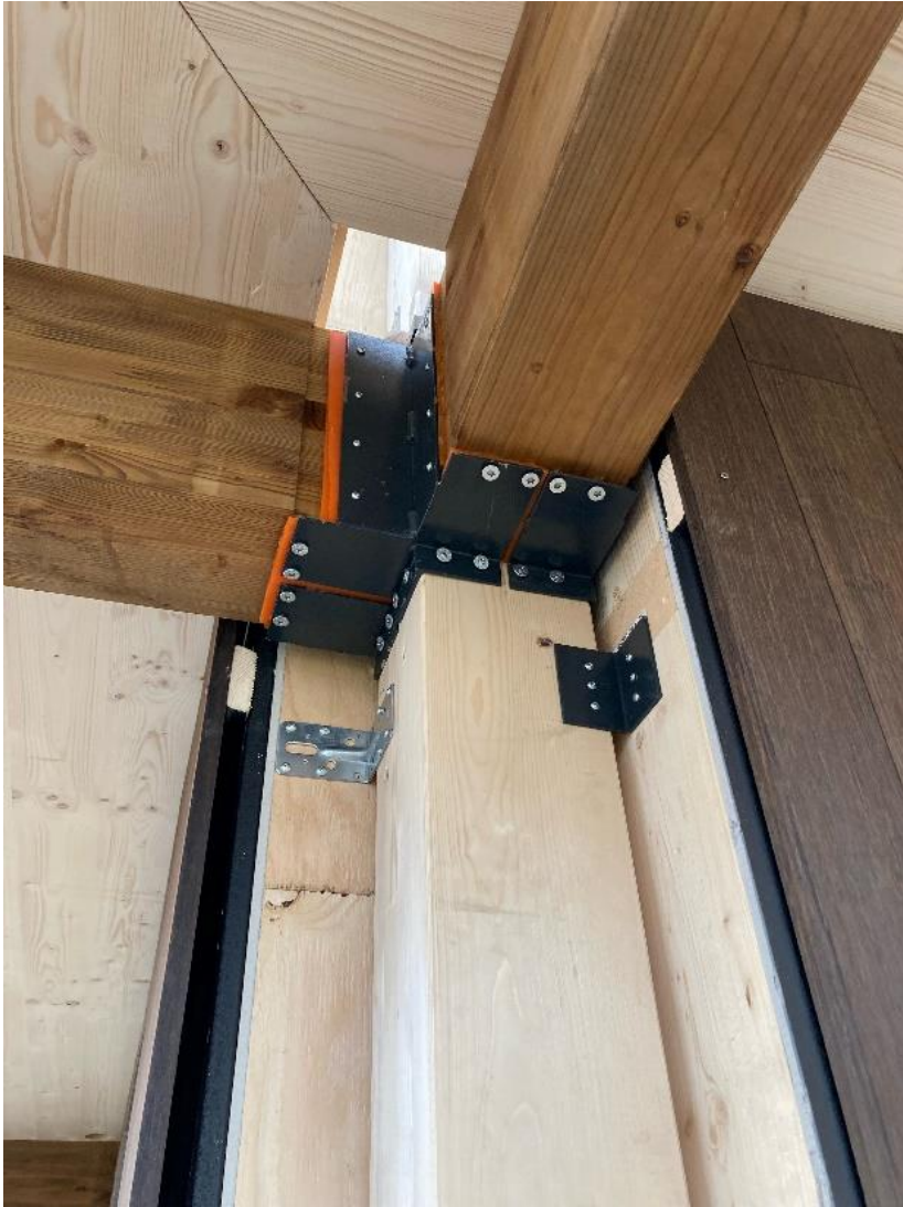
Figuur 28 – Aansluiting consoles (1)
