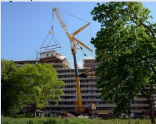
Figuur 6 – Uithijzen tunnels
