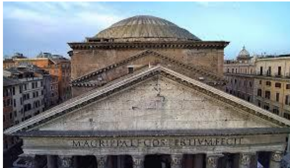
Figuur 1: Dak van het Pantheon, Rome en zijn betonnen koepel
